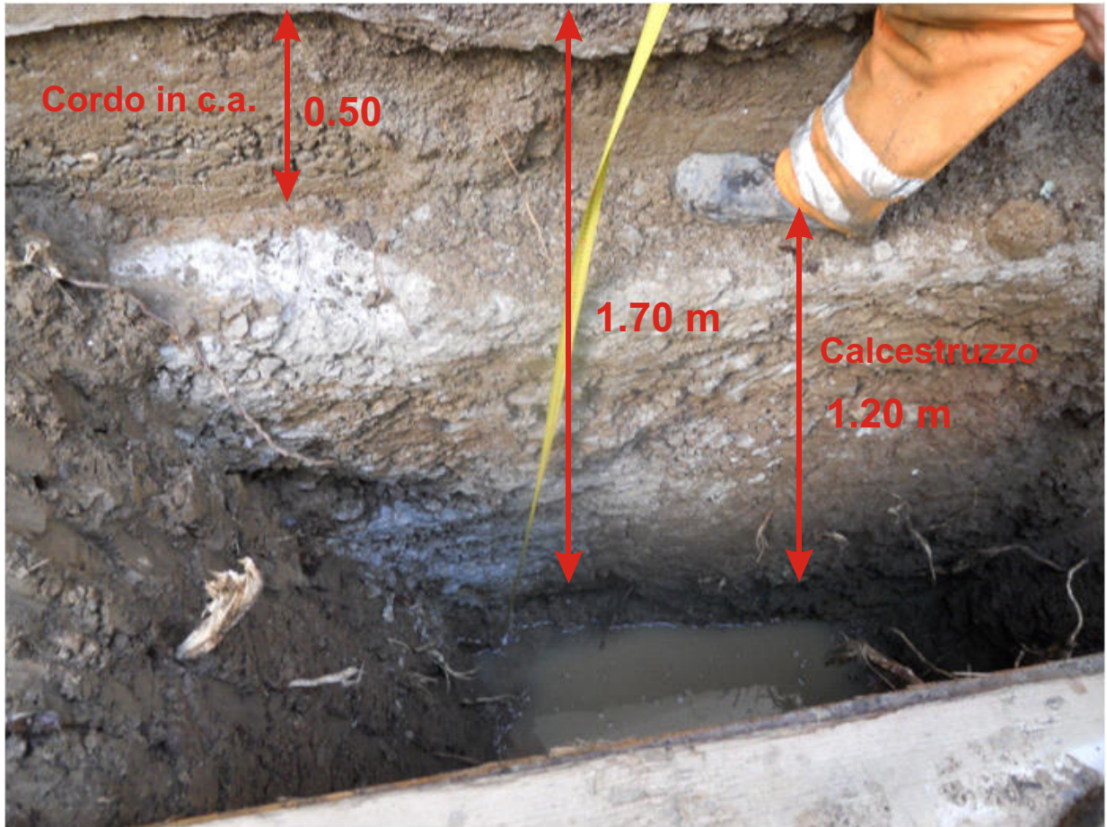
Foto 7- 8 Scavo geognostico in adiacenza alla fondazione
