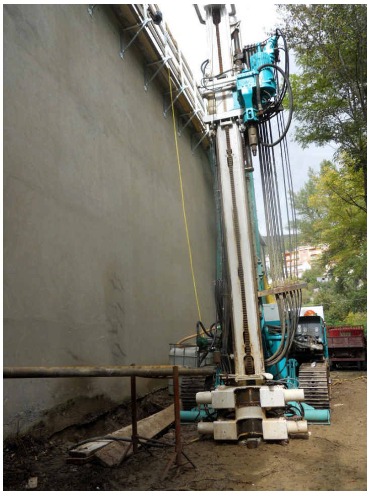
Foto 1 – Ubicazione sondaggio S1
