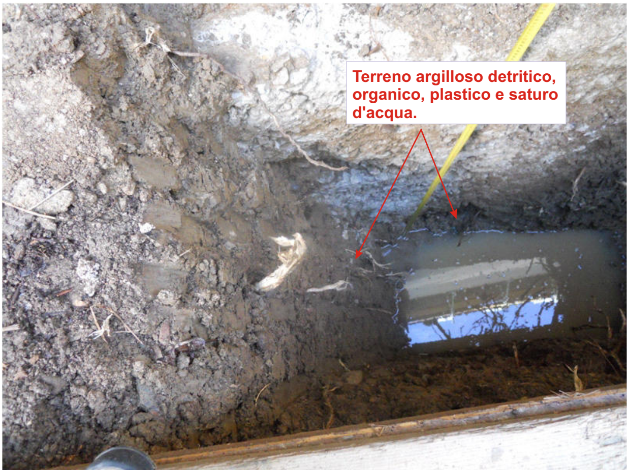
Foto 7- 8 Scavo geognostico in adiacenza alla fondazione
